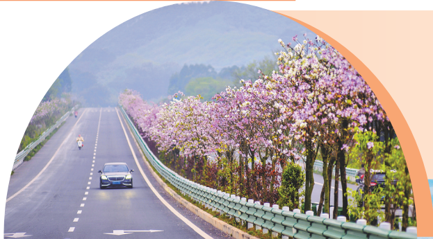
▲由中交一航局承建的玉林市路网升级改造项目总投资额75.66亿元。图为玉林市园博园至五彩田园公路景观。(钟勇 摄)
