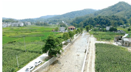
上珍村正在拓宽村中河道。
