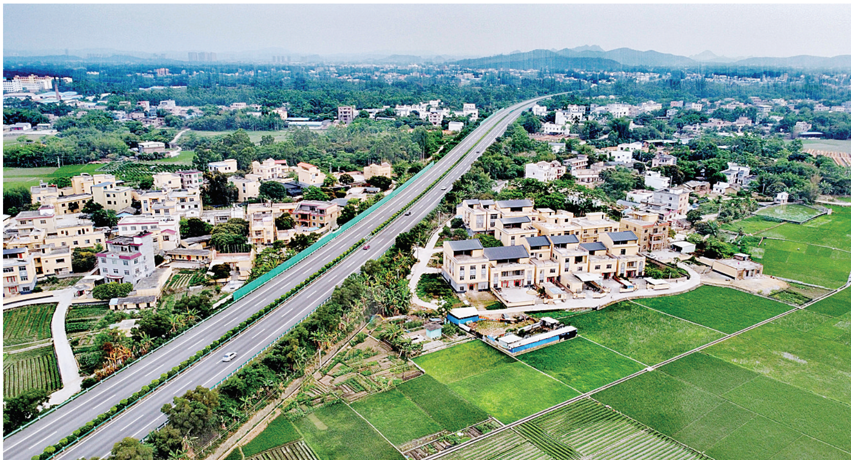
▲北流市西垌镇良村片风貌。
