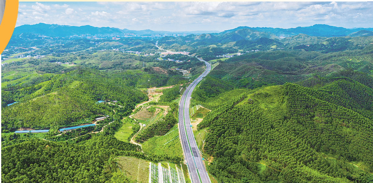
▲由中交一航局承建的玉湛高速途经玉林陆川县、博白县,2020年9月建成通车后,玉林与湛江两地车程由原来的4小时缩短至1.5小时。(张钰斌 摄)
