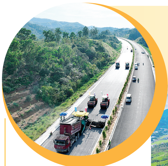
▲由中交一航局承建的浦清高速途经玉林博白县、陆川县、北流市,全长125.654公里,总投资额144.26亿元,预计2022年底建成通车。图为浦清高速路面三标段正在进行沥青摊铺。(张钰斌 摄)
