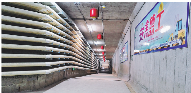
▲由中交一航局承建的玉林市二环东(南)路道路及地下综合管廊项目已建设完成并进入运营期。(张钰斌 摄)
