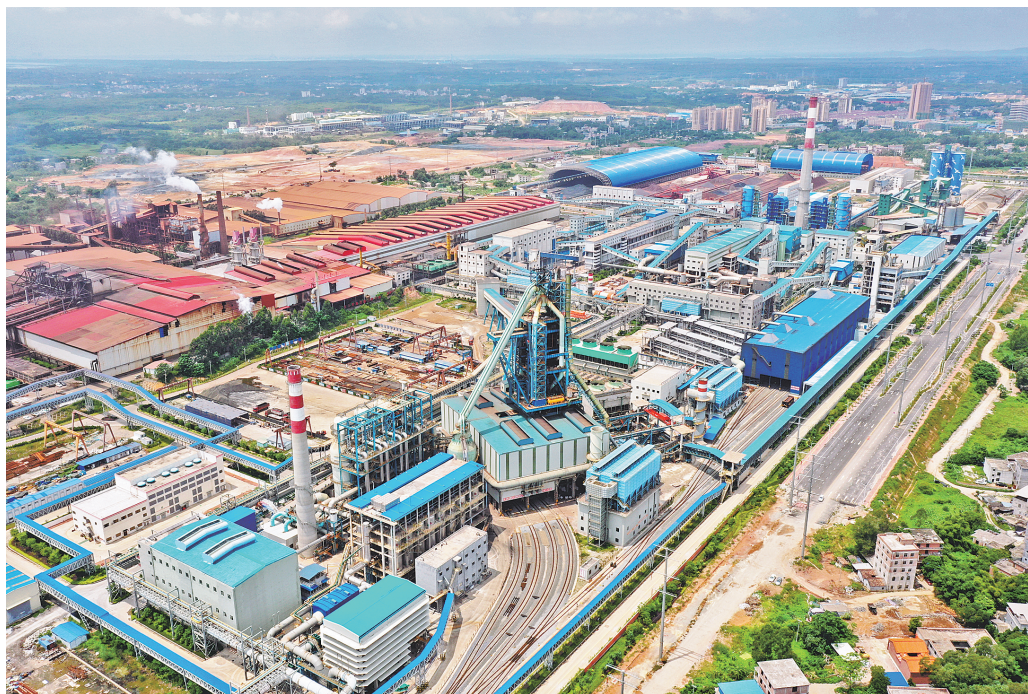
▲位于龙潭产业园区的广西柳钢中金不锈钢有限公司镍铁冶炼项目已全线投产。
