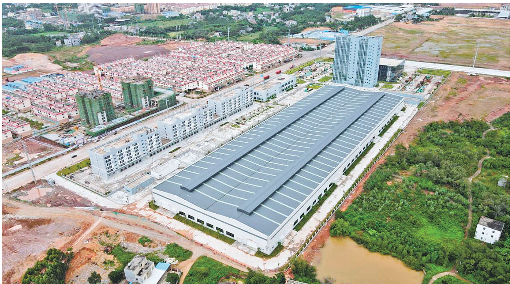
▲玉林龙潭产业园区高端不锈钢项目二期工程通过竣工验收。
