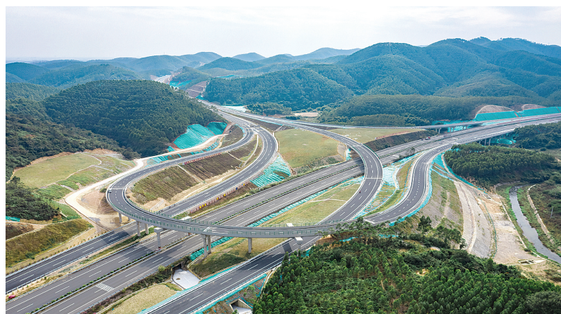
松铁高速松旺南枢纽互通。(王湫 摄)
