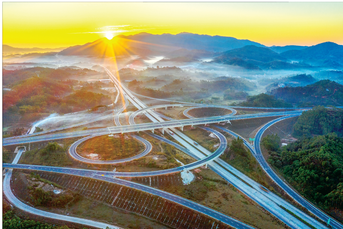
兴业县境内交通便捷。图为荔玉高速党州互通。(朱权 摄)
