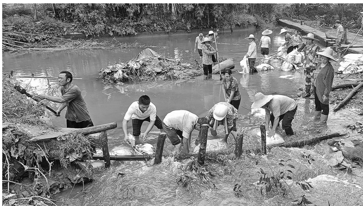
▶抢修人员在用沙袋封堵堤坝缺口。
