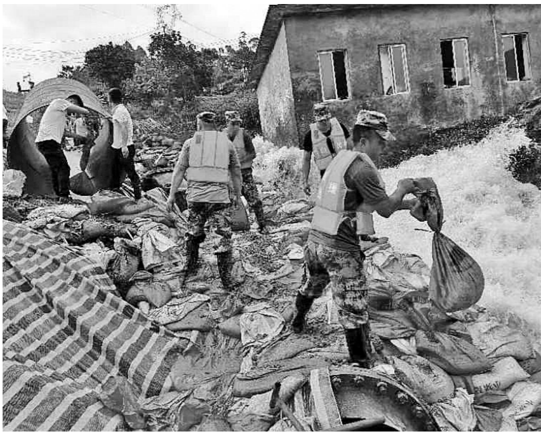
▲应急民兵搬运沙袋紧急垒筑防护墙。
