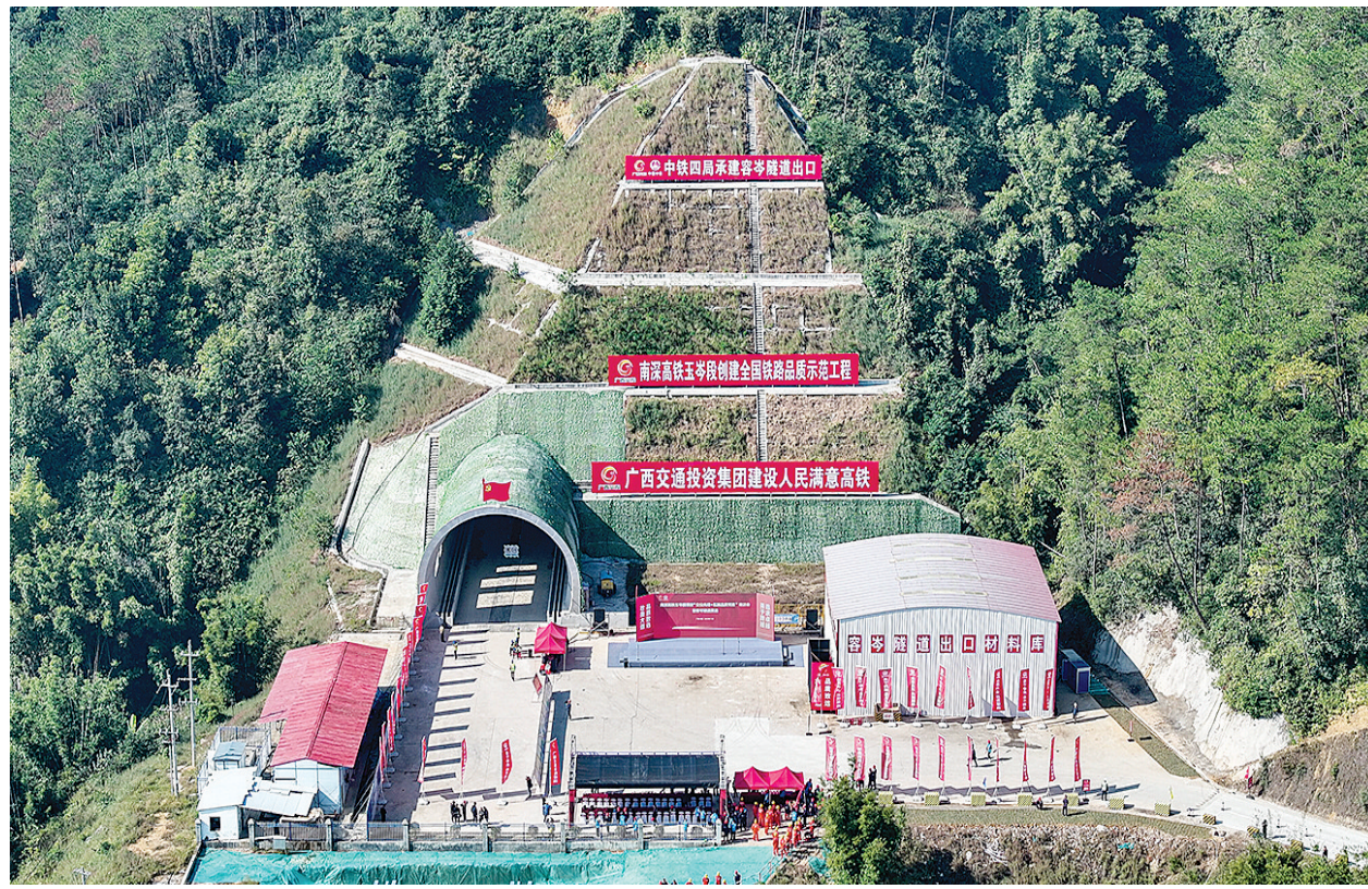
这是容岑隧道建设现场(11月21日摄,无人机照片)。
