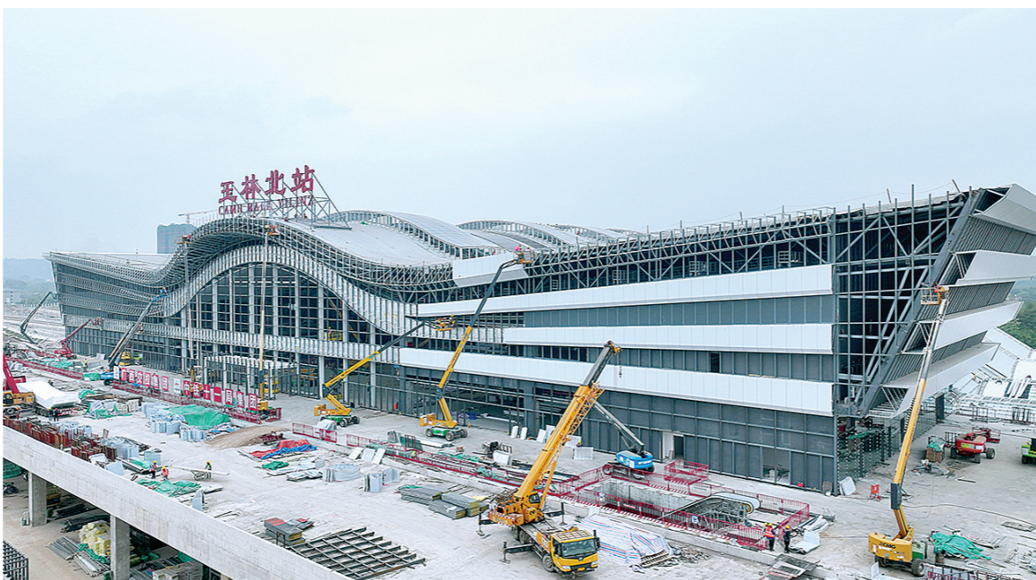
玉林北站时尚、美观、大气的幕墙外形已初步呈现。(本报记者 蒋金泰 摄)
