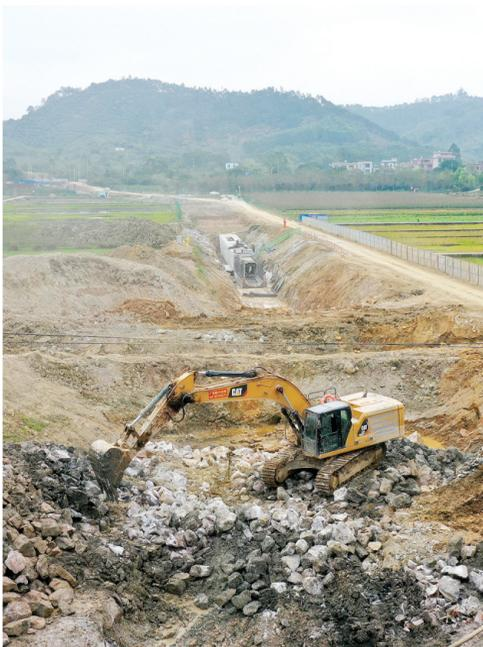
龙云灌区蟠龙水库至中甘岭水库引水渠正在开挖建设。
