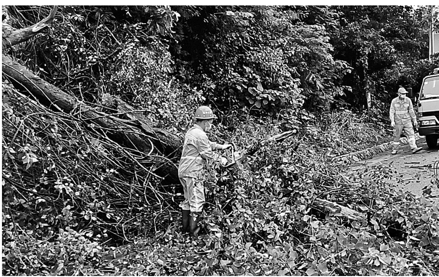
玉林城区公路养护中心养护工人在国道324线福州至昆明公路K1464+600兴业县路段清理倒伏路树。(罗建国 摄)
