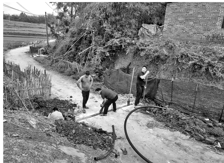
施工人员在埋设引水管。
