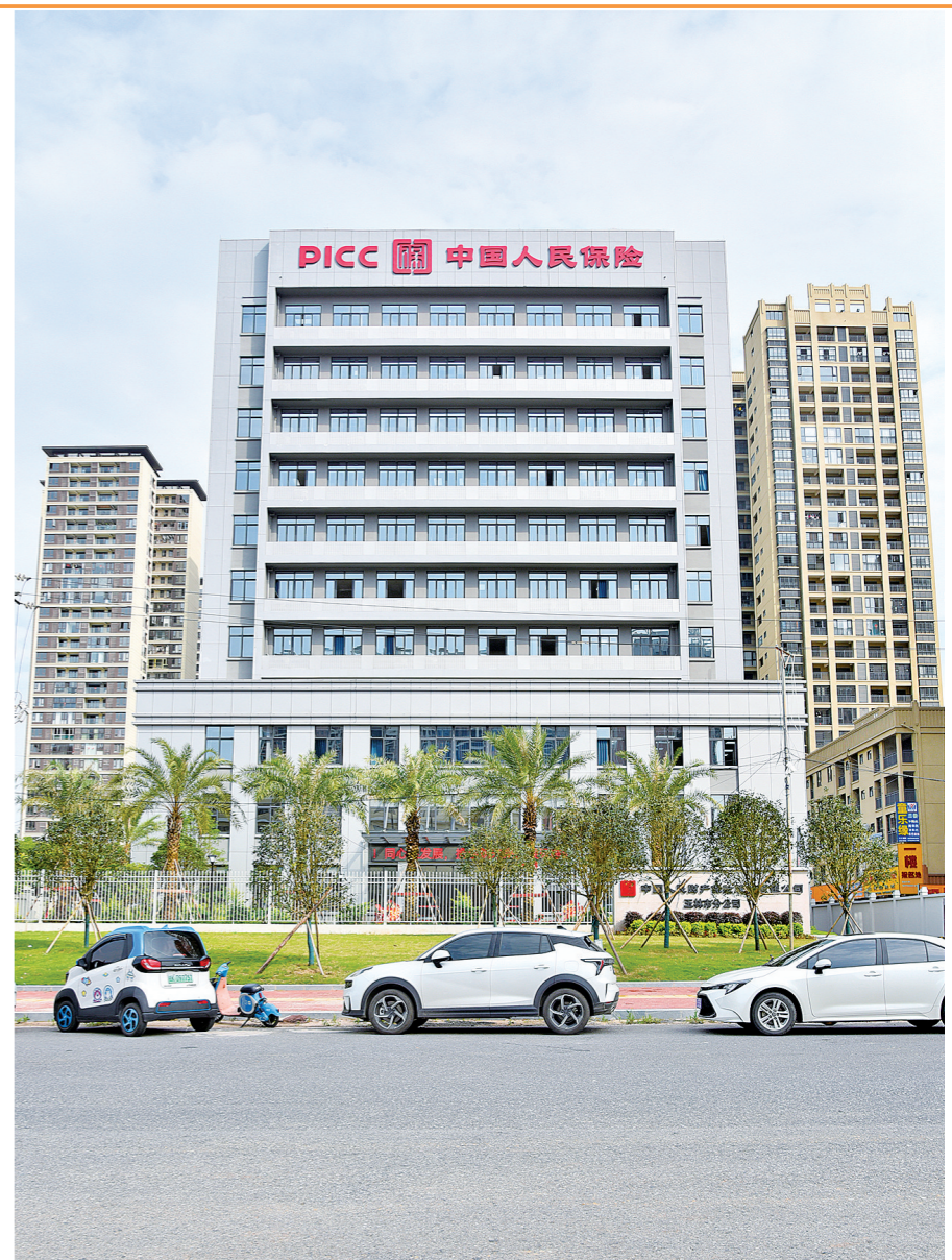
中国人民财产保险股份有限公司玉林市分公司办公大楼外景。
