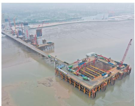
6月8日拍摄的杭州湾跨海铁路桥北航道桥8号主塔墩桩基施工平台(无人机照片)。
