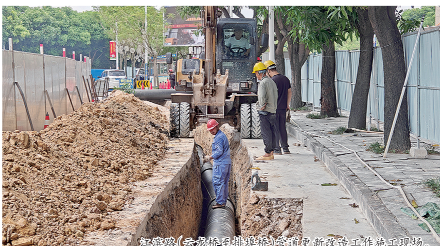
江滨路(云龙桥至排排桥)管道更新改造工程施工现场。
