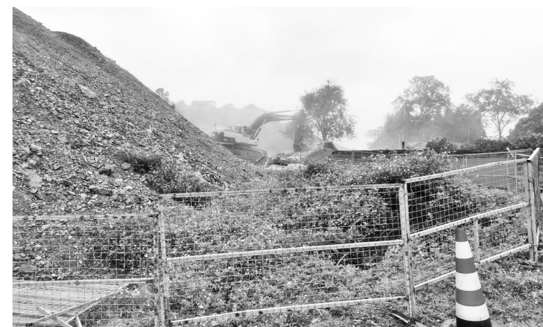
浦清高速博白段拆除最后的堵点。
